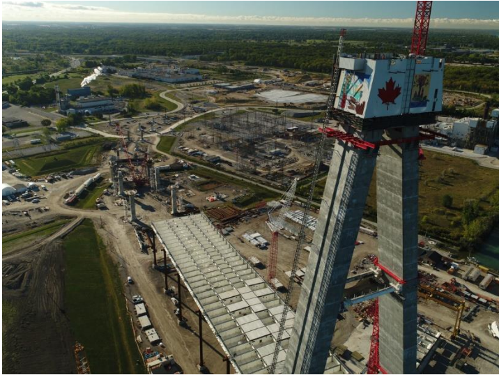
Construcción de la plataforma y tramos laterales del puente en Canadá
