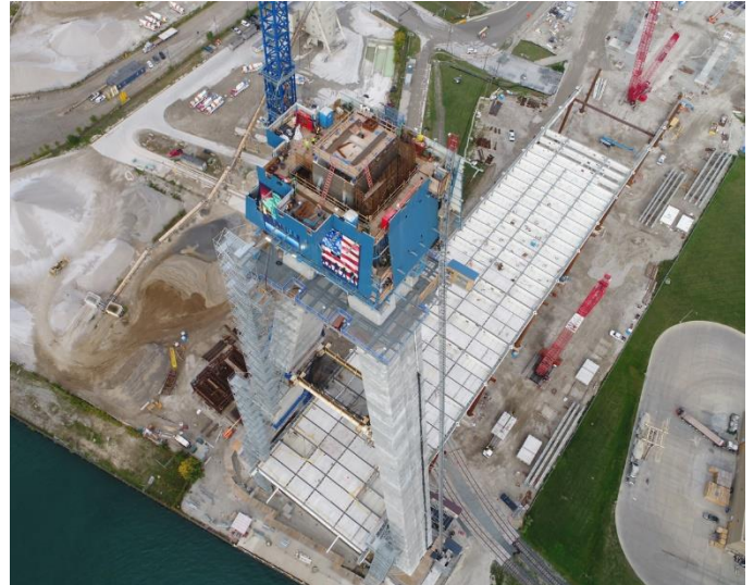
Construcción de la torre y la plataforma del puente en E.E. U.U.
