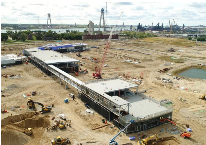
Construcción de las instalaciones en el Punto de entrada estadounidense
