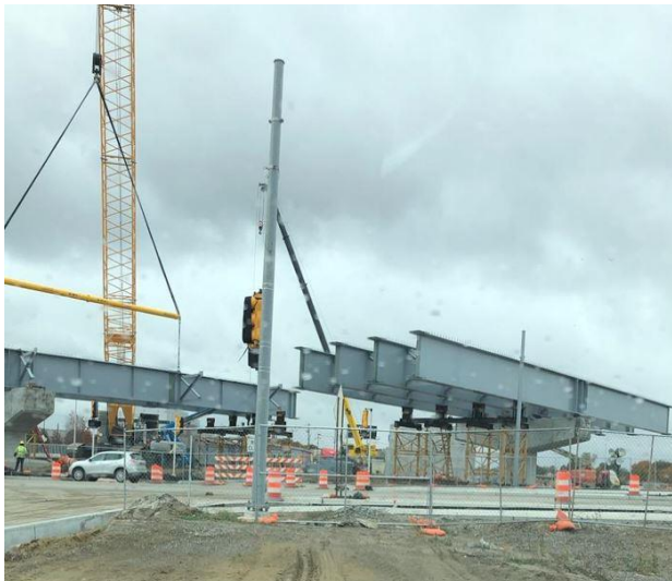
Instalación de vigas en la I-75
