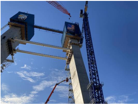
Trabajo en la torre del puente en E.E. U.U.
