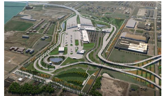
Futuras rampas de la I-75 que se conectarán con el Punto de entrada estadounidense
