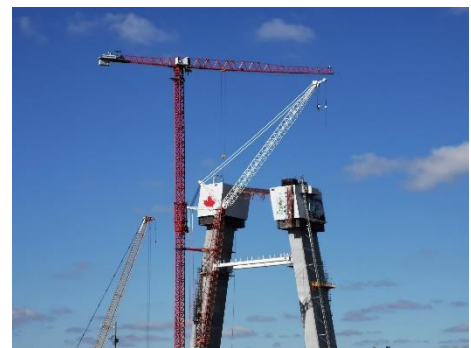
Trabajo en la torre del puente en Canadá
