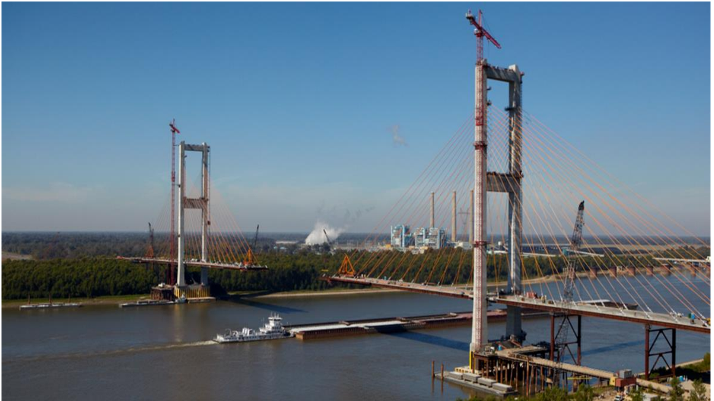
Ejemplo del método de construcción en voladizo: John James Audubon Bridge, Baton Rouge, Louisiana
