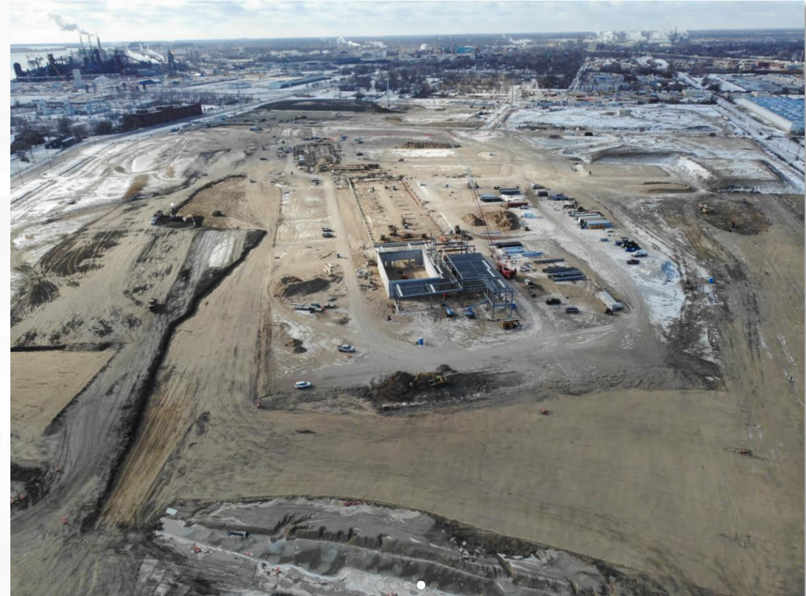
Instalación de drenajes de mecha en el Punto de entrada estadounidense
