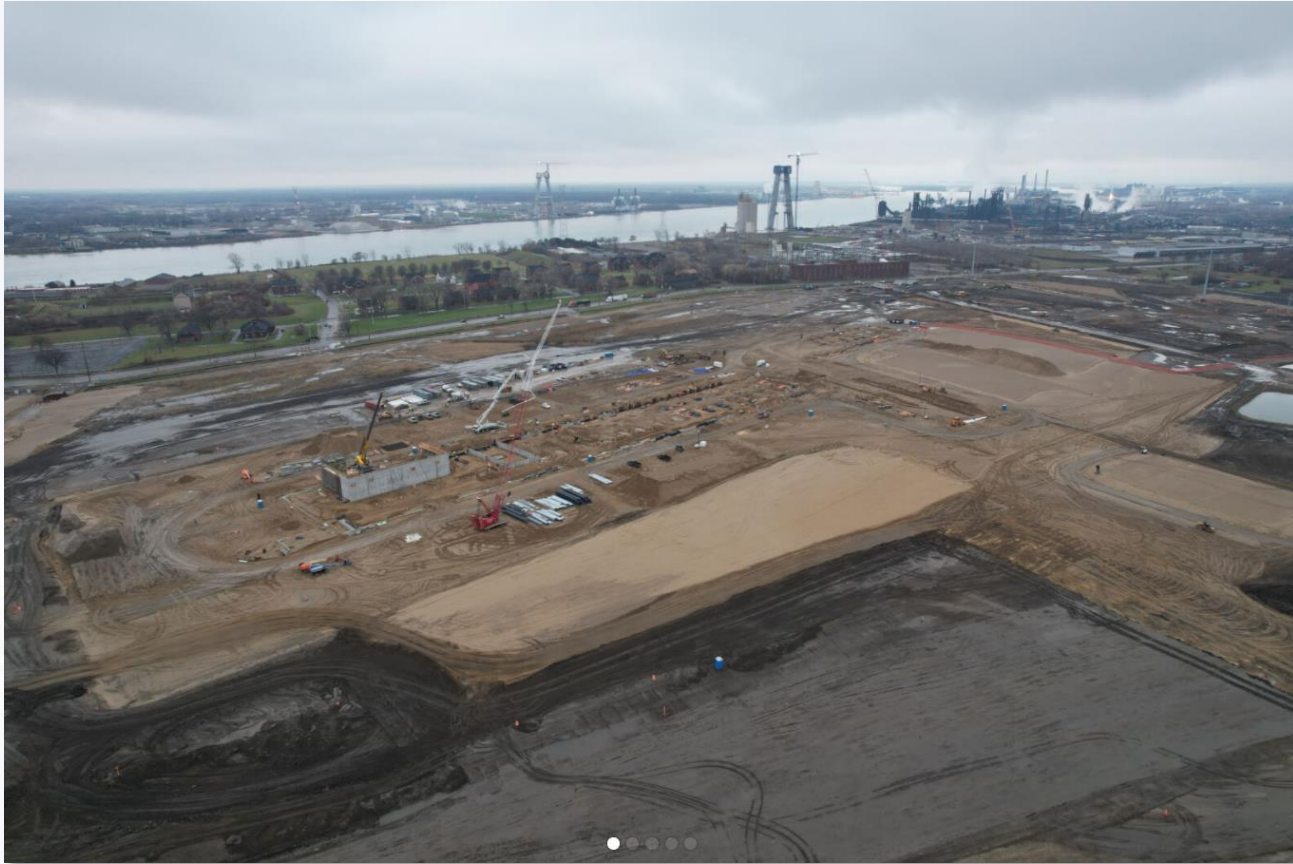
Movimiento de tierras en el Punto de entrada estadounidense
