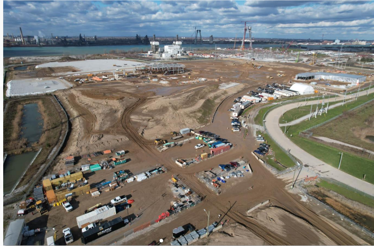
Construcción del edificio principal en el Punto de entrada canadiense
