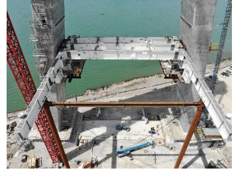
Construction du tablier du pont
