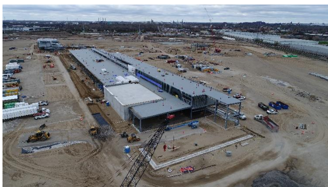
Construction des installations du point d'entrée américain.
