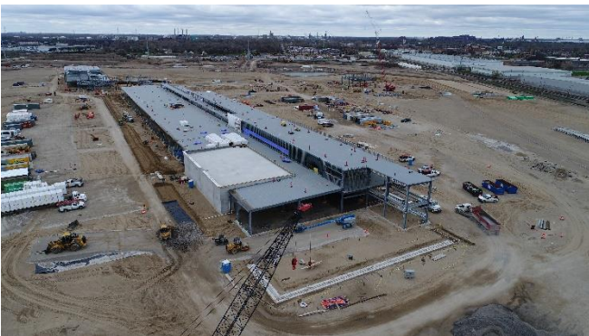
Construcción de las instalaciones en el Punto de entrada estadounidense
