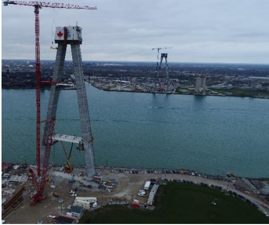
Construcción de las torres del puente en Canadá y E.E. U.U.
