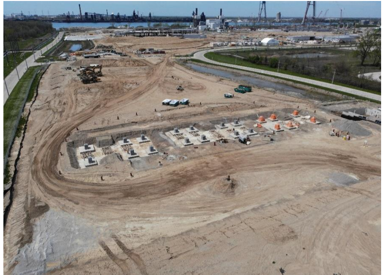
Construcción de las casetas de peaje del Punto de entrada canadiense.
