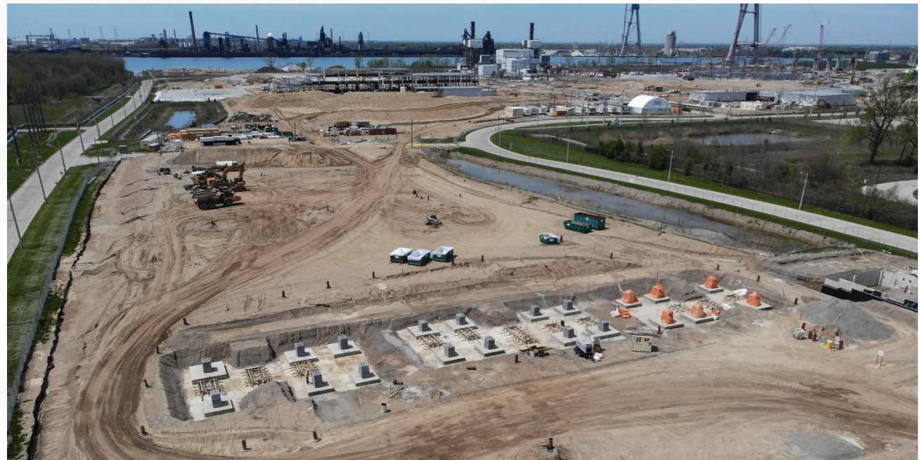
Punto de entrada canadiense, construcción de las casetas de peaje
