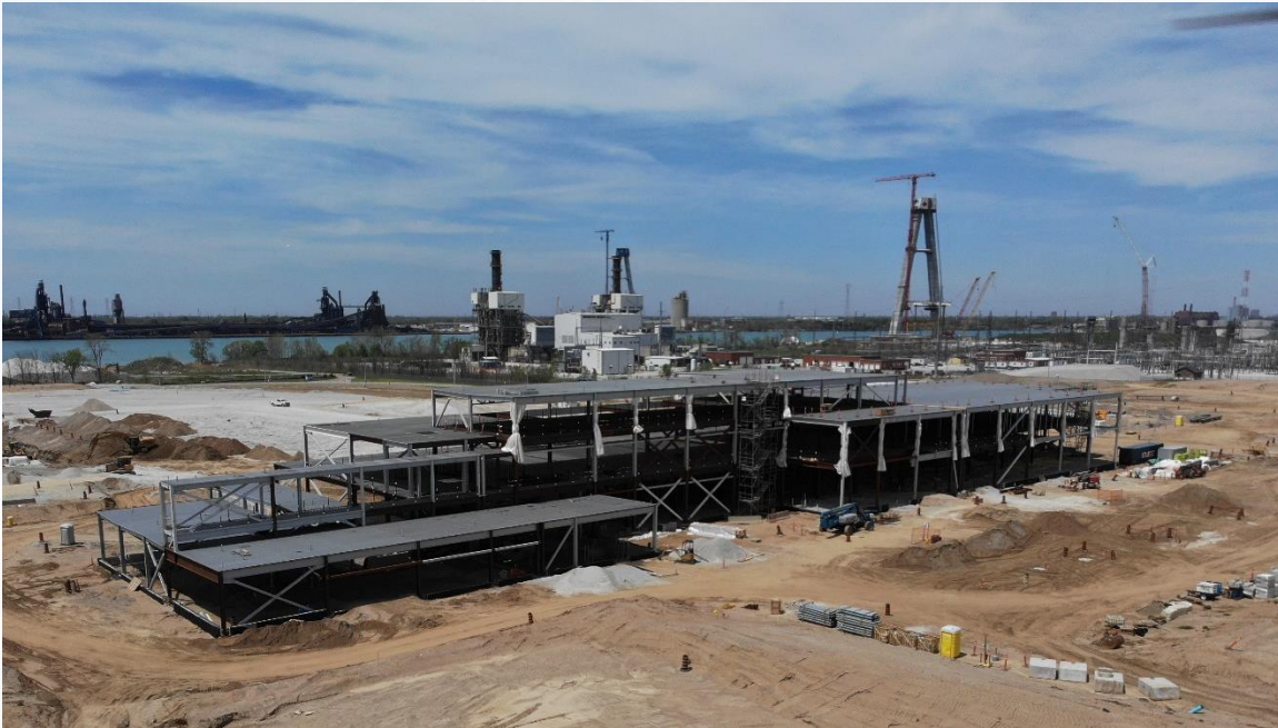
Punto de entrada canadiense, construcción del edificio principal
