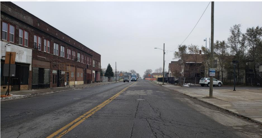
Junction Street de cara al norte, antes
