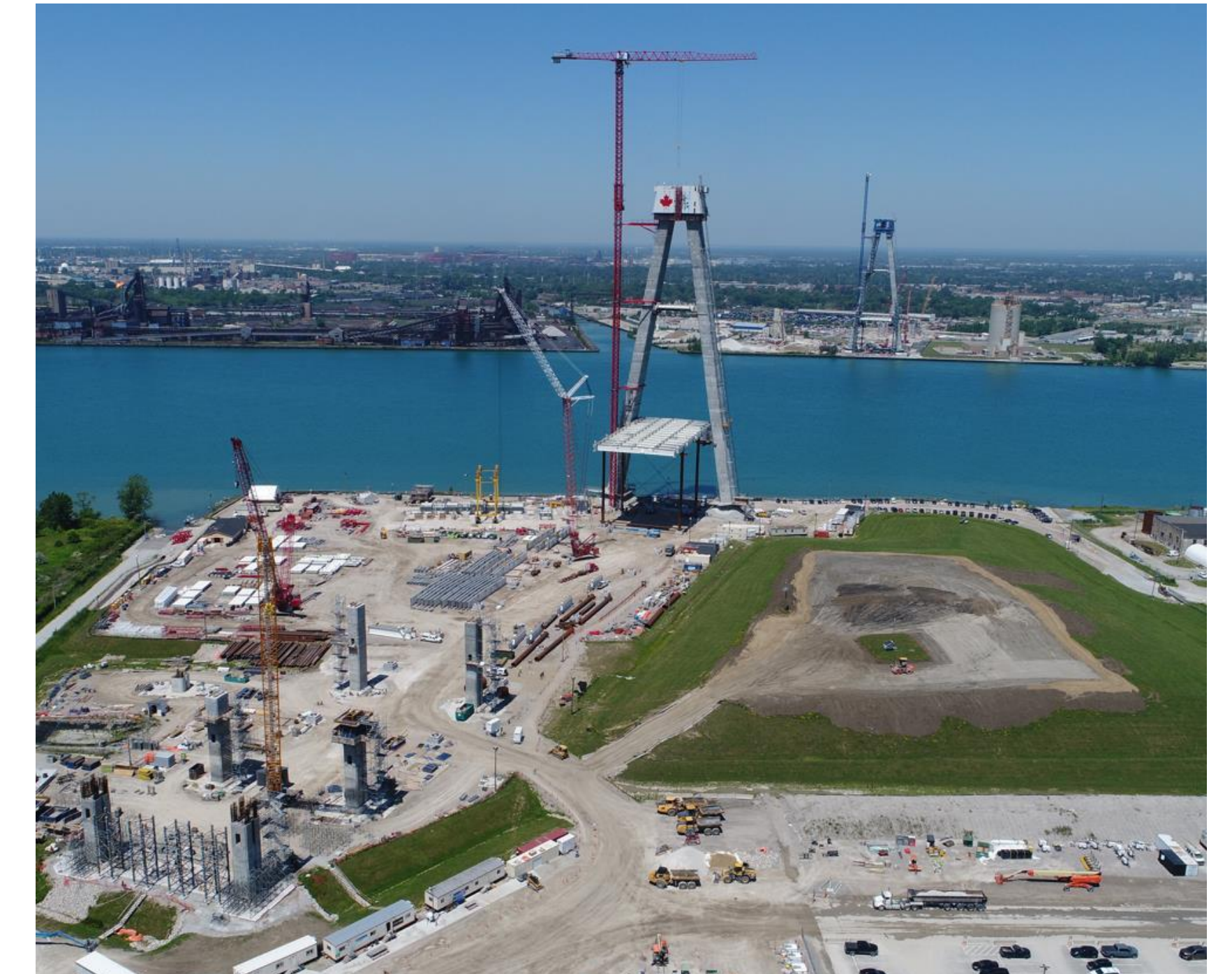
Chantier canadien du pont : travaux sur les pylônes et les travées latérales
