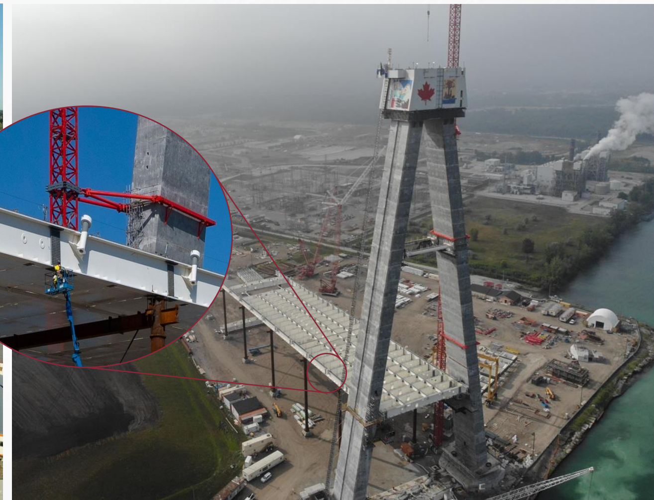
Construction du tablier du pont au Canada
