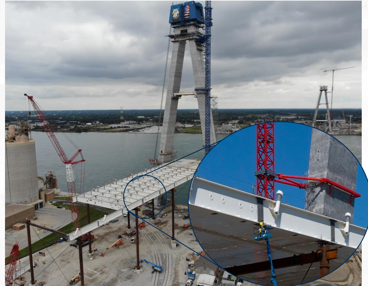
Installation de poutres de pont aux États-Unis
