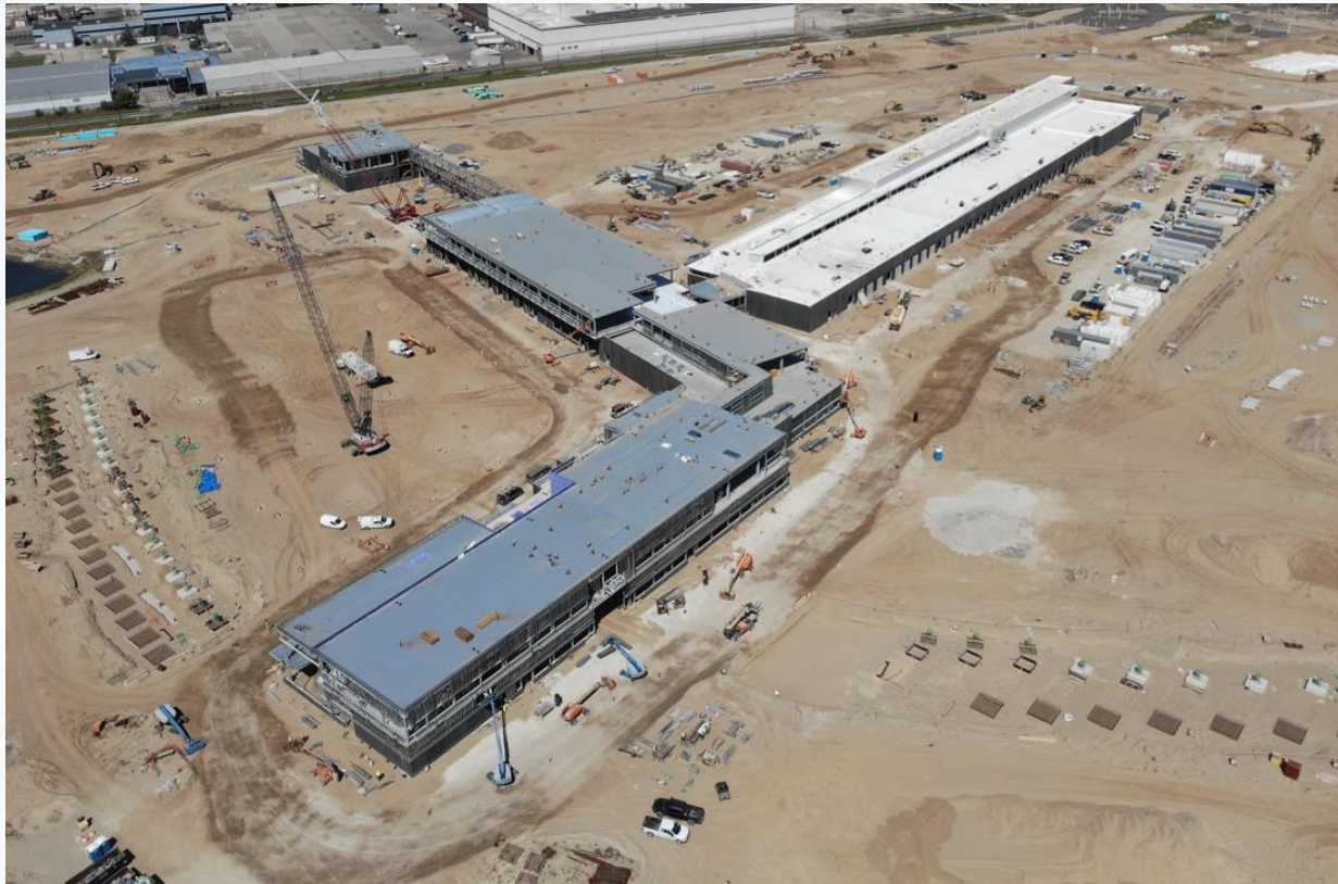
Construction du bâtiment au PDE américain
