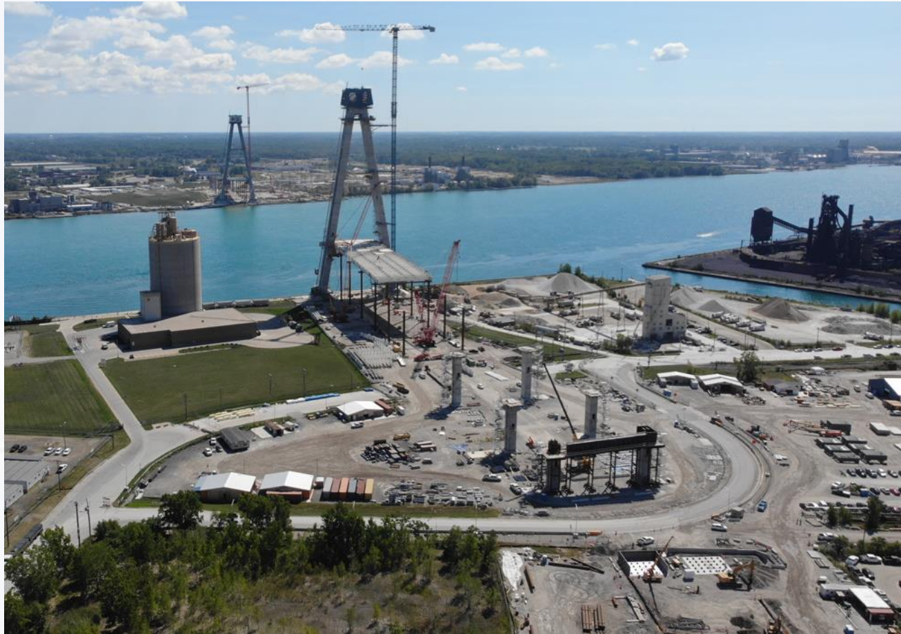
Chantier américain : travée arrière et tours du pont
