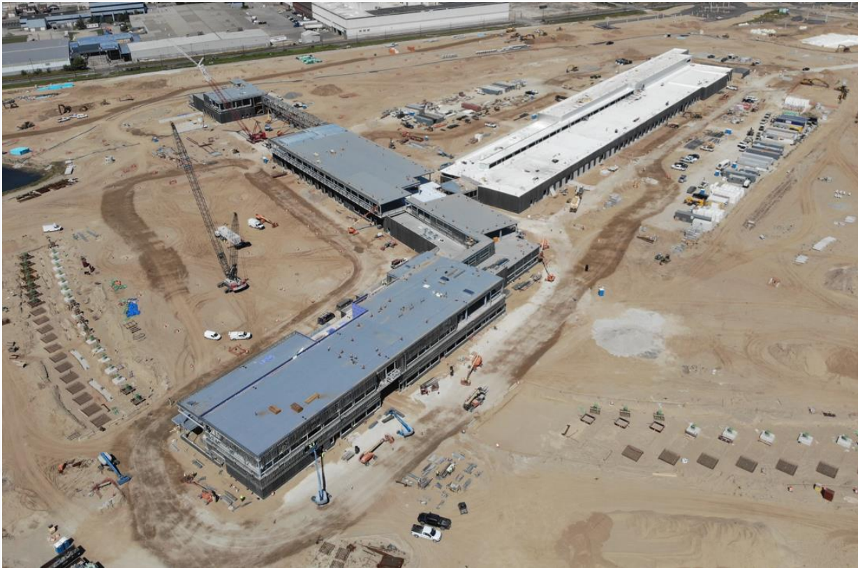
Construction du bâtiment au PDE américain
