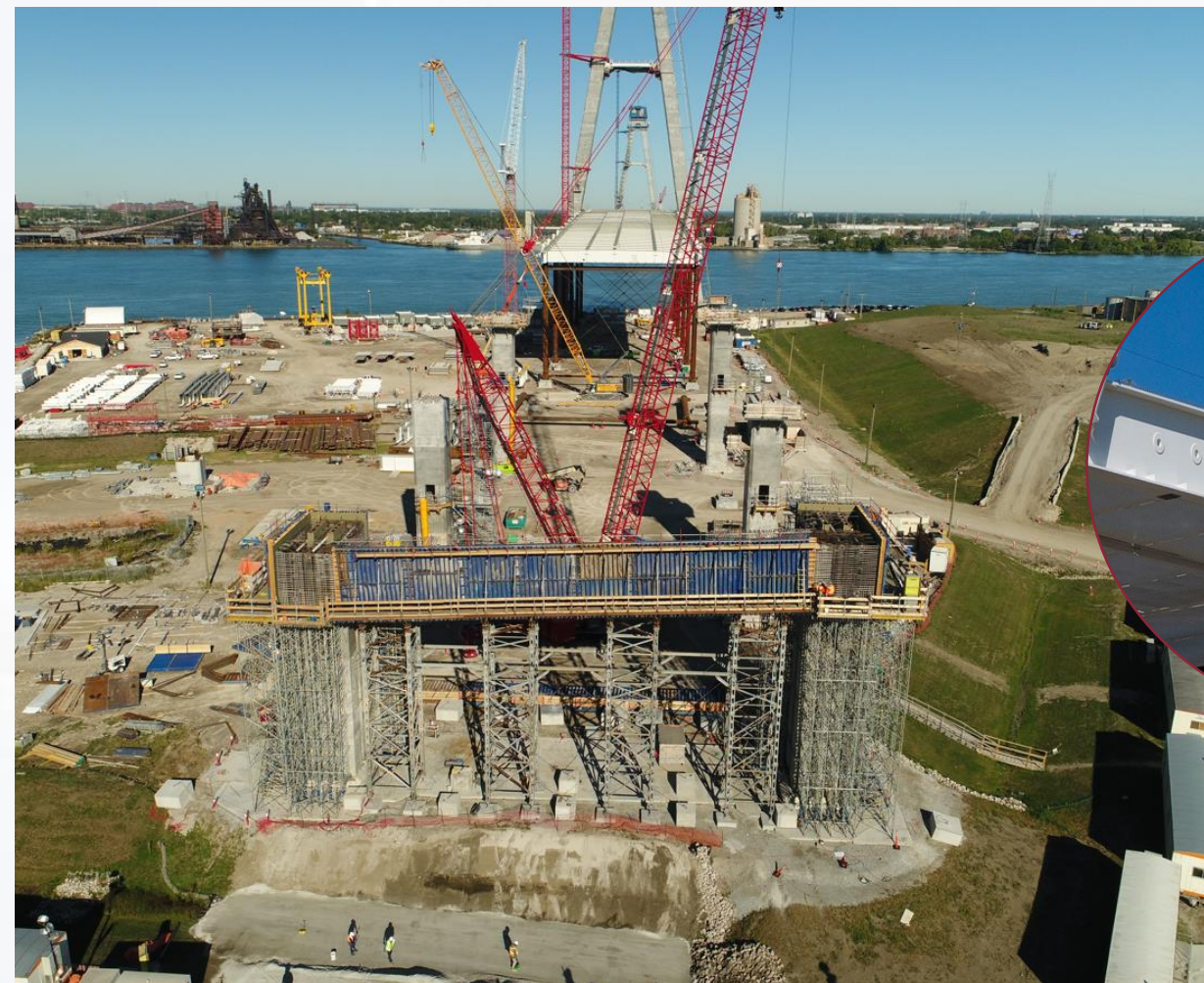
Chantier canadien du pont : travée arrière et tours
