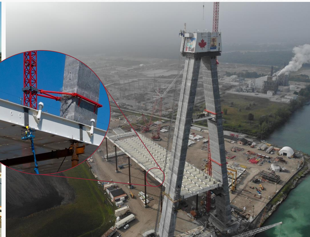
Construction du tablier du pont au Canada
