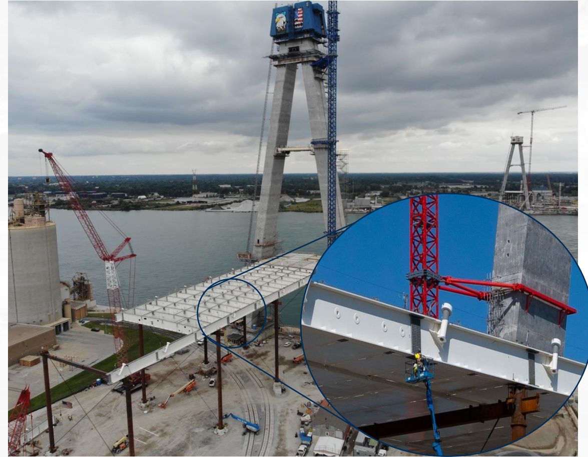
Instalación de vigas para la plataforma del puente de EE. UU.
