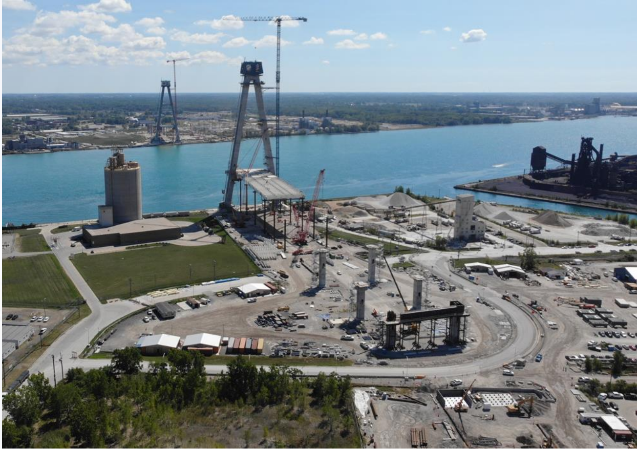
Tramo posterior del puente y las torres del puente en el emplazamiento en EE. UU.
