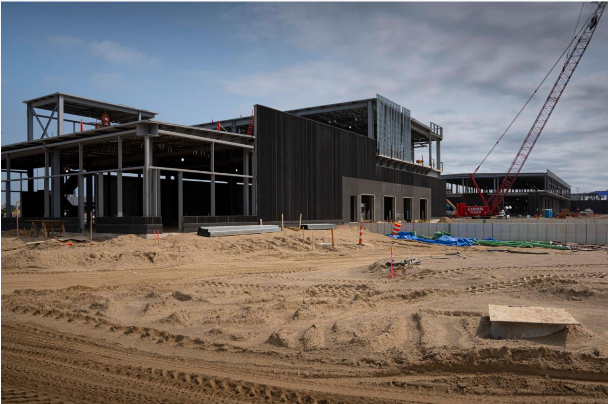
Construcción de edificios en el Punto de entrada estadounidense
