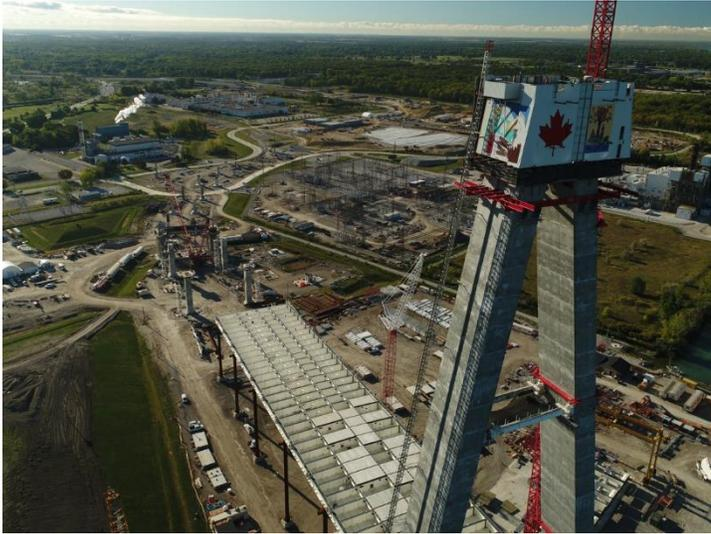
Construction de tabliers et de travées latérales du pont au Canada
