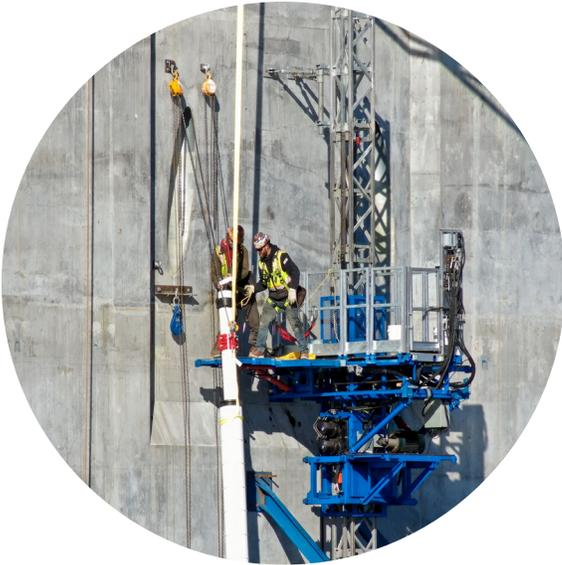
**Étape 4:** Les ouvriers postés sur l'échafaudage prennent l'âme et l'introduisent dans la boîte d'ancrage située à l'intérieur de la tour. Une autre équipe de travailleurs postés à l'intérieur de la boîte d'ancrage prend l'âme, l'ancre et la fixe à l'aide d'une cale en acier.
