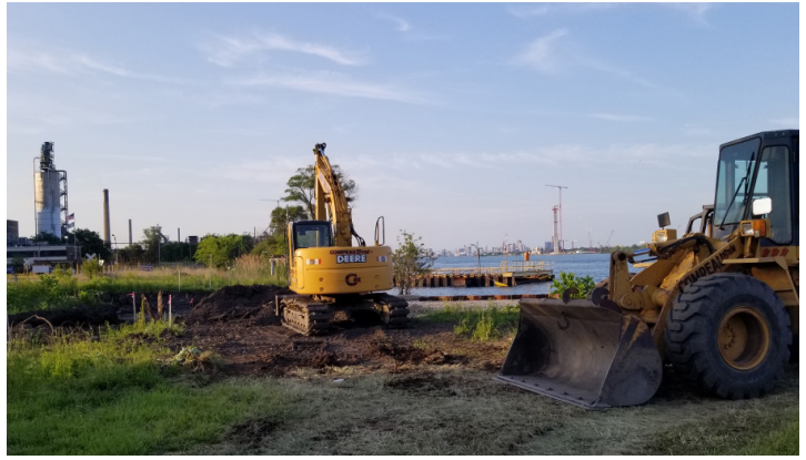
Le nivellement du site a eu lieu cet été pour préparer la construction de l'aire d'observation à River Rouge.
