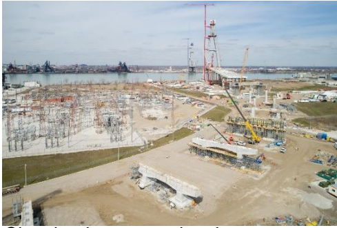
Chantier de construction du pont au Canada
