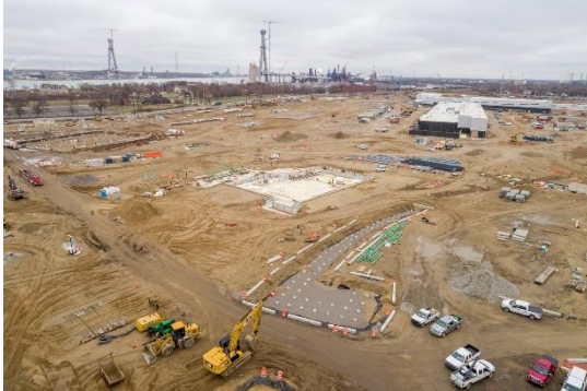
Construction au point d'entrée américain
