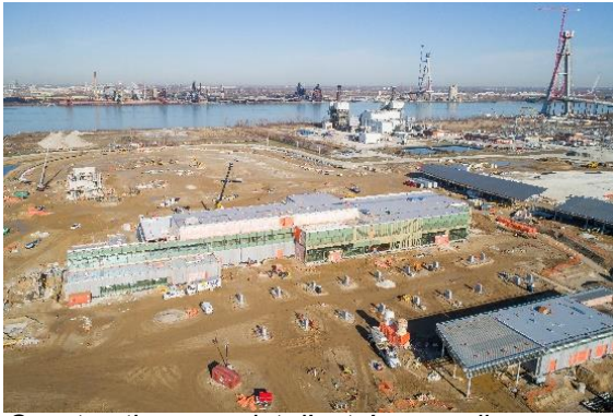
Construction au point d'entrée canadien
