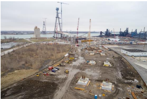
Chantier de construction du pont aux
