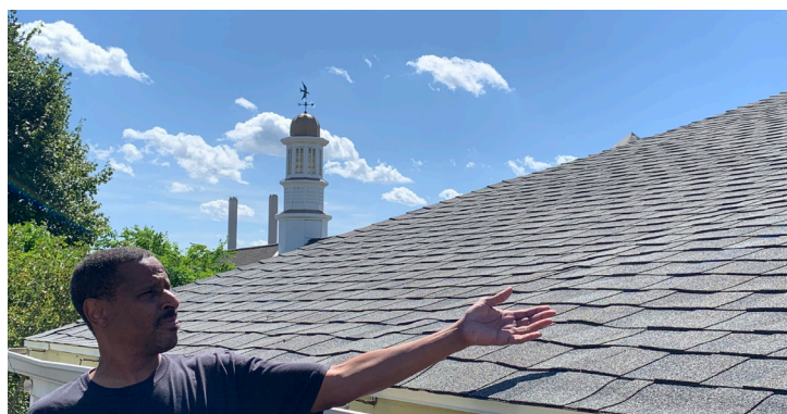
Forest Hudson présente le nouveau toit à pignon du gymnase de la Delray Neighborhood House.
