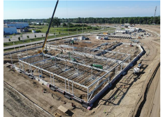
Construction d'un bâtiment au point d'entrée canadien
