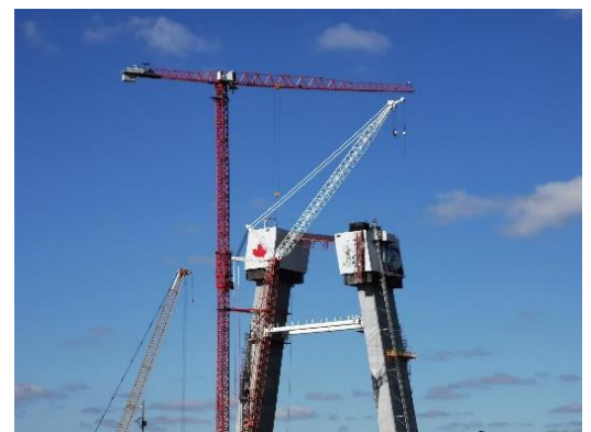
Travaux sur la tour du pont au Canada
