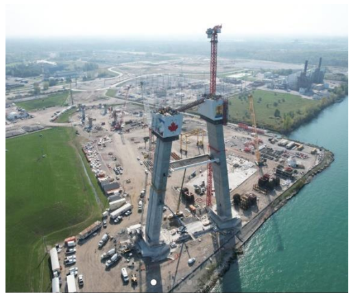
Travaux sur la tour du pont au Canada
