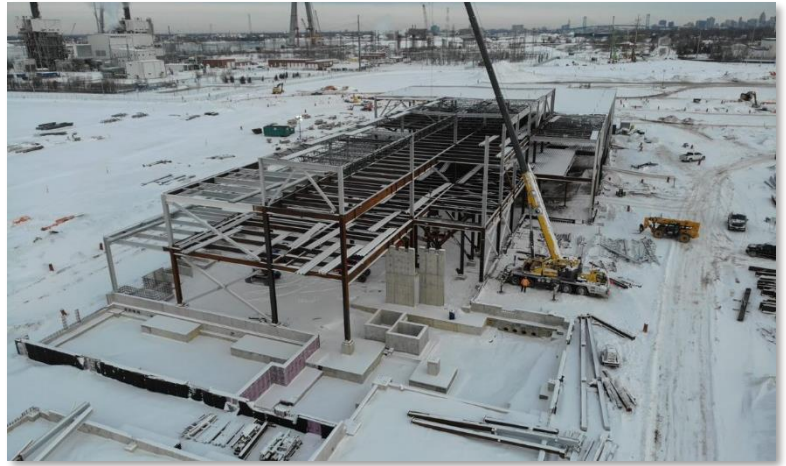
Construcción de edificios en el Punto de entrada canadiense
