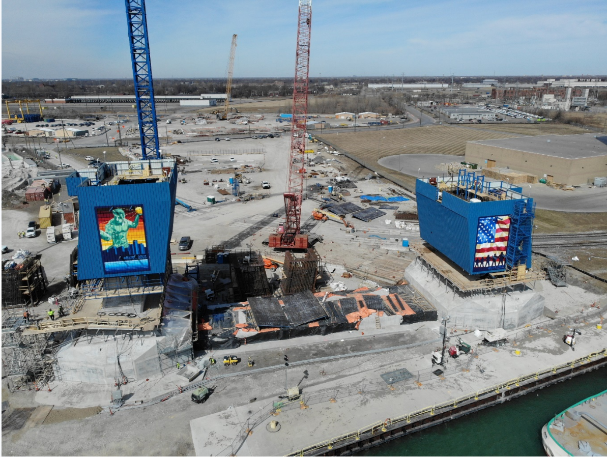
Travaux sur la tour du chantier du pont aux États-Unis
