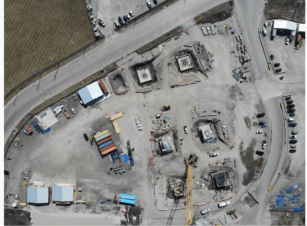
Travaux sur le côté et la travée arrière du chantier du pont aux États-Unis
