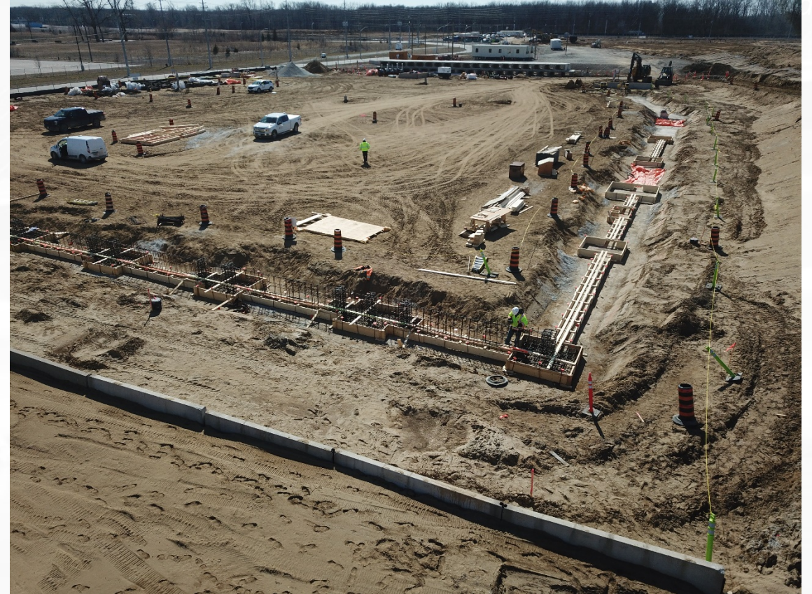
Fondations du bâtiment du point d'entrée canadien
