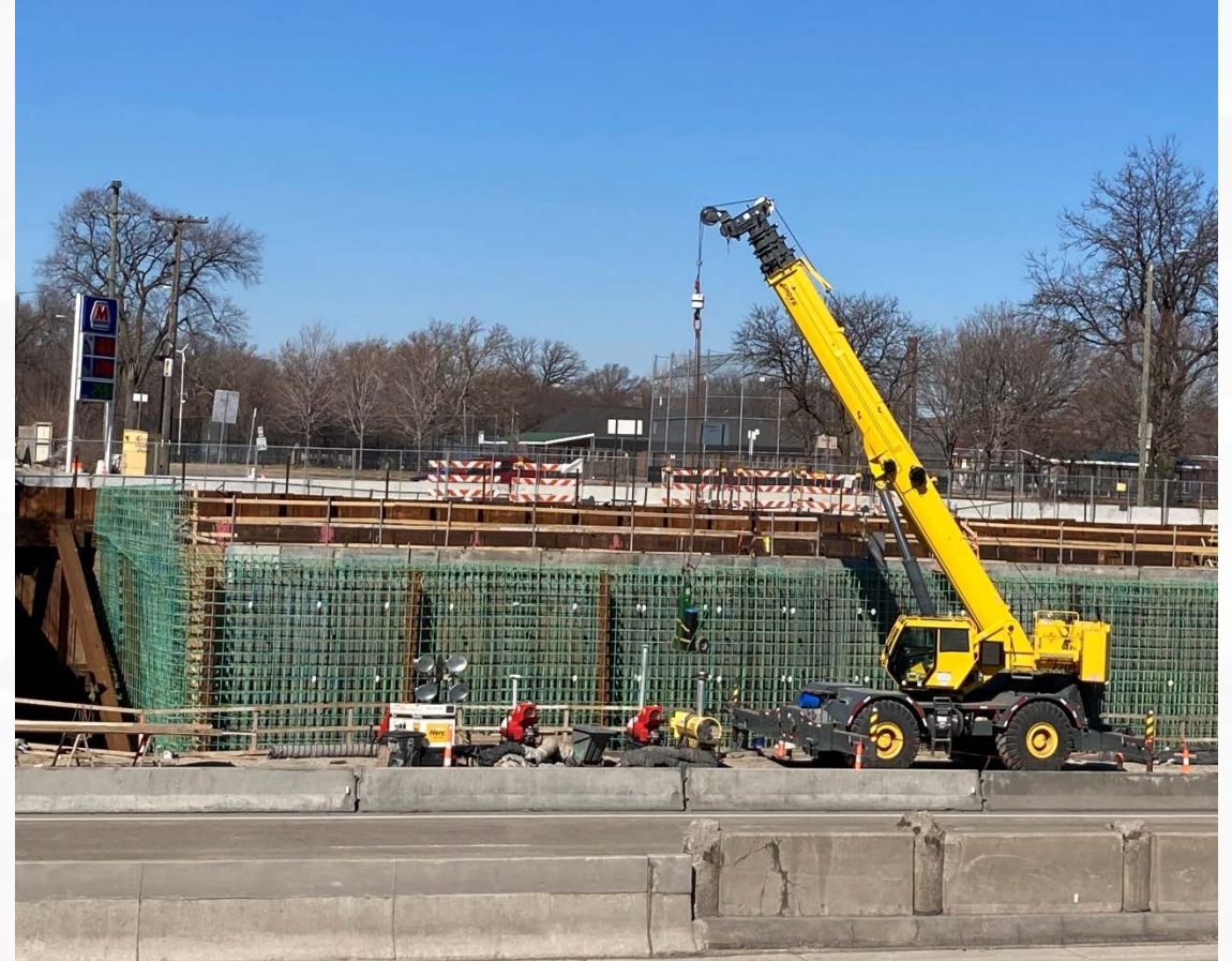
Travaux de culée du pont de la rue Clark dans le cadre de l'échangeur du Michigan
