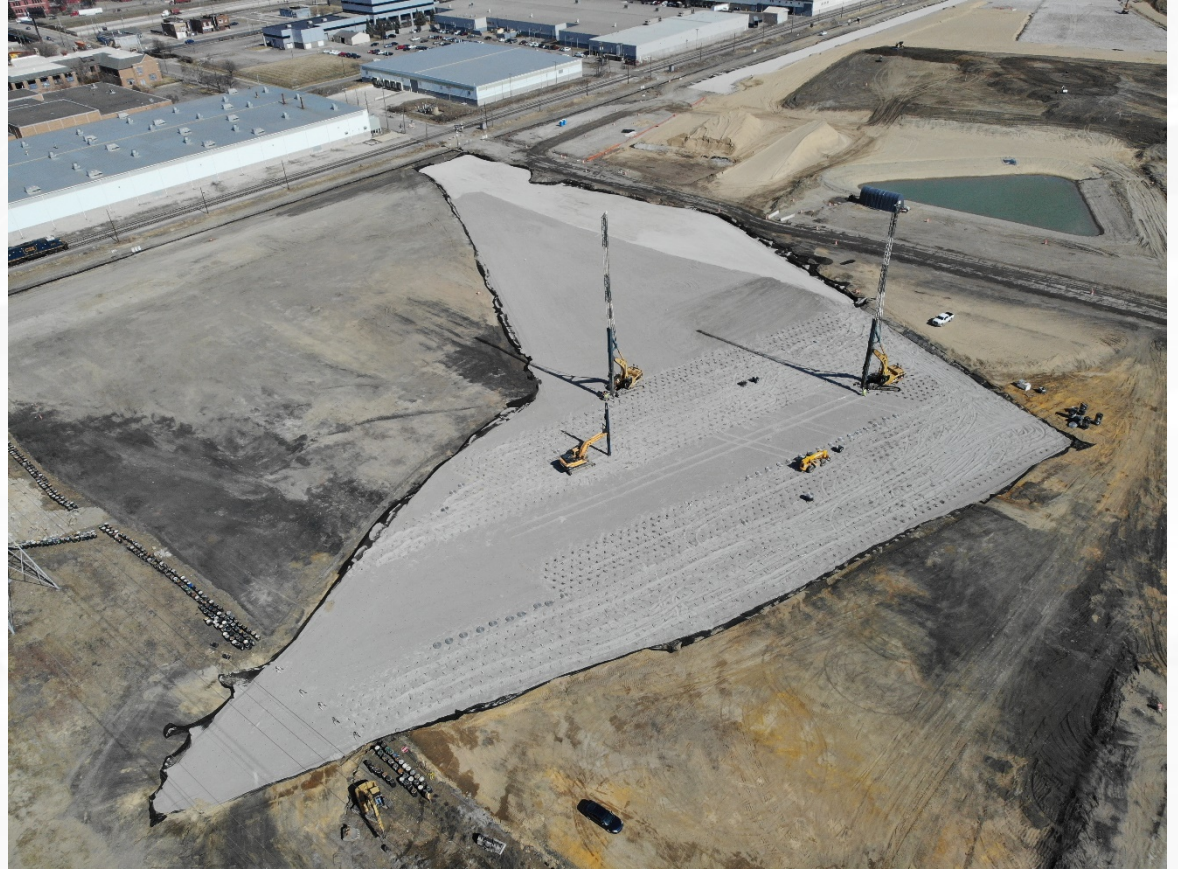
Installation de drains verticaux au point d'entrée américain
