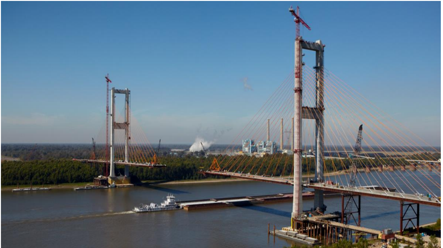
Exemple de méthode de construction par encorbellement : Pont John James Audubon, Bâton-Rouge, Louisiane
