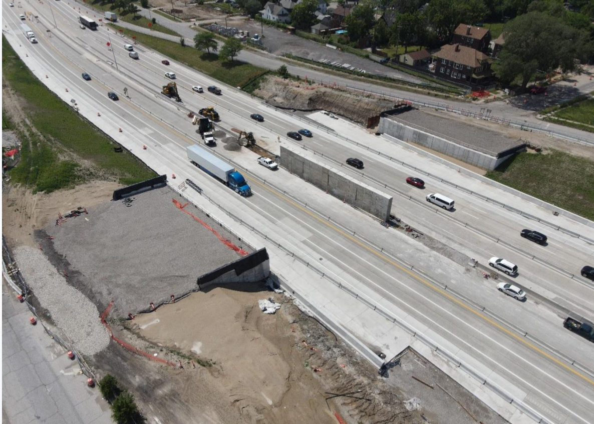
Construcción de un puente vial en la Intersección en MI
