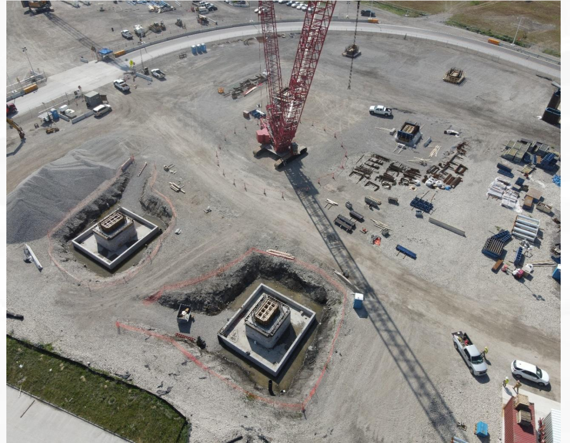
Trabajo en el tramo posterior del puente en EE. U.U.
