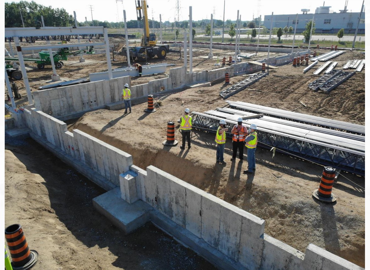
Construcción de edificios en el Punto de entrada estadounidense
