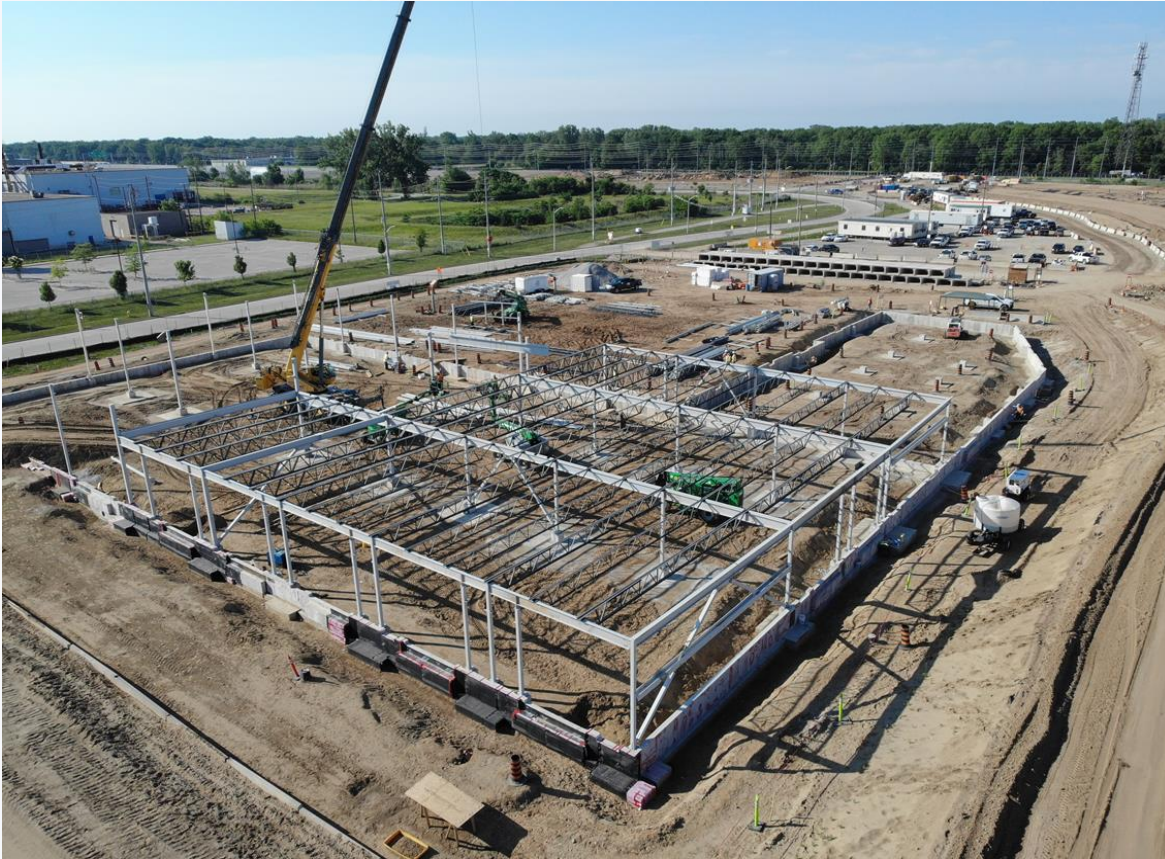
Construcción de edificios en el Punto de entrada canadiense
