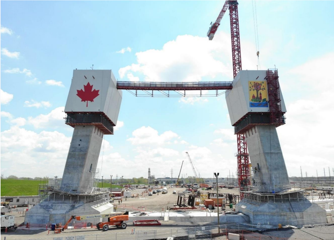
Trabajo en la torre del puente en Canadá
