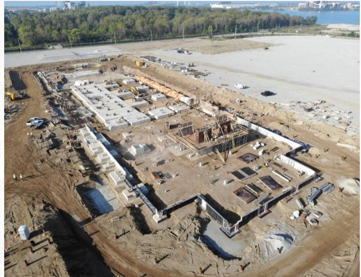
Construction des bâtiments du PDE canadien
