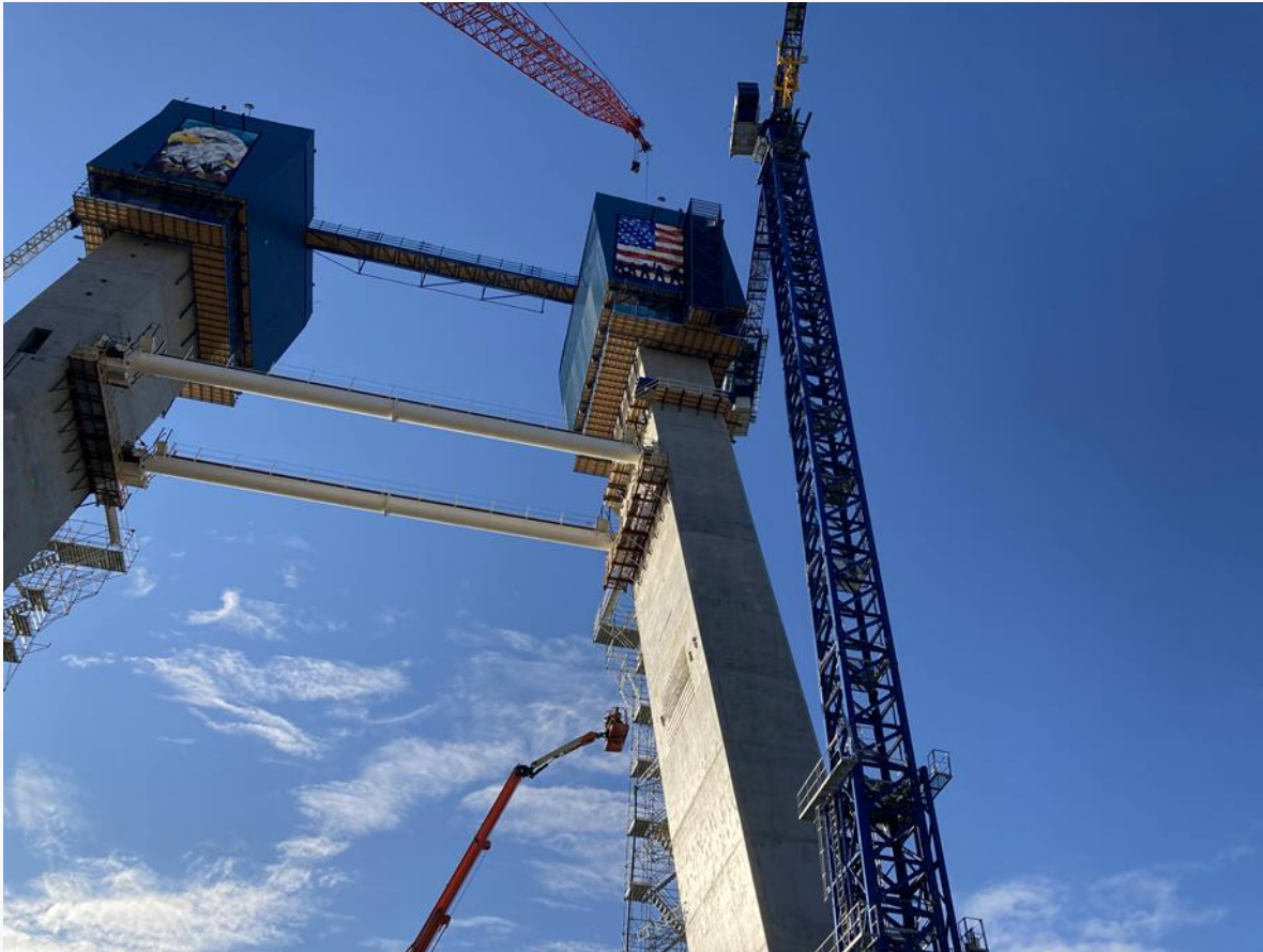
Travaux sur la tour du pont aux États-Unis
