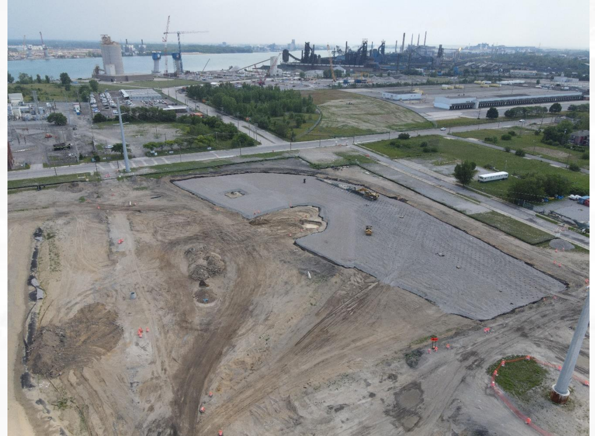
Installation de drains verticaux au PDE américain
