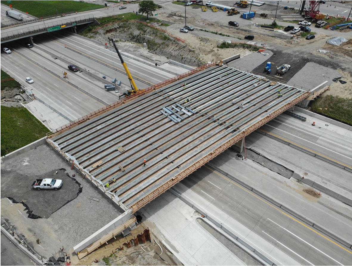
Construction d'un pont routier de l'échangeur du MI
