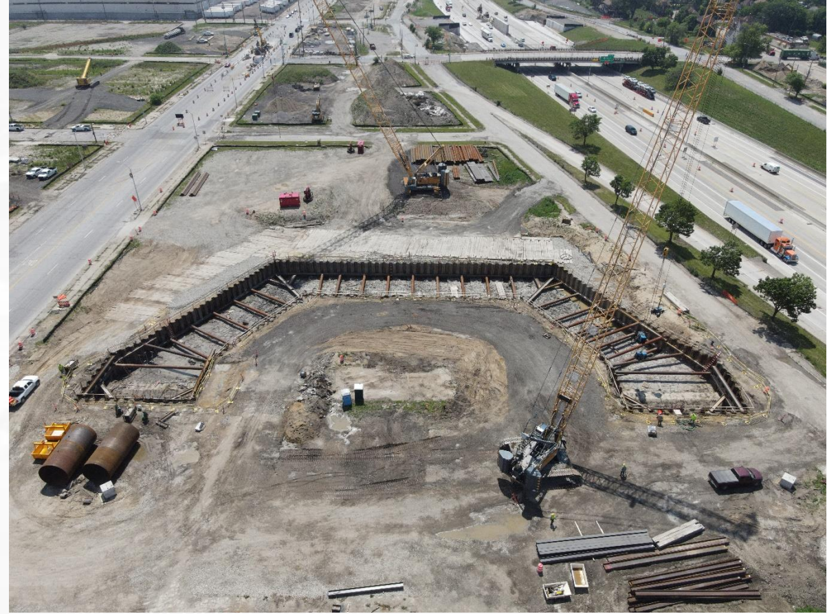
Construction du siphon de la rue Cavalry
