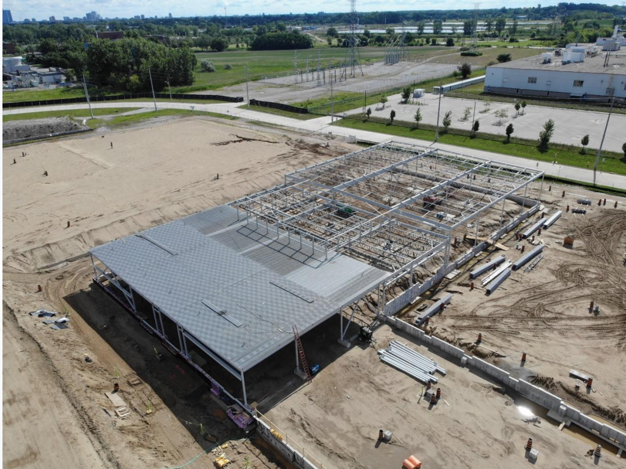
Construction des bâtiments du PDE canadien
