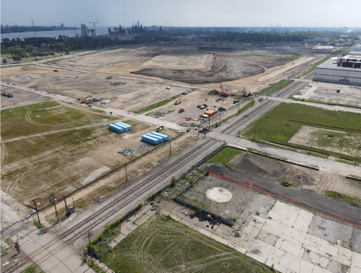
Travaux de terrassement au PDE américain
