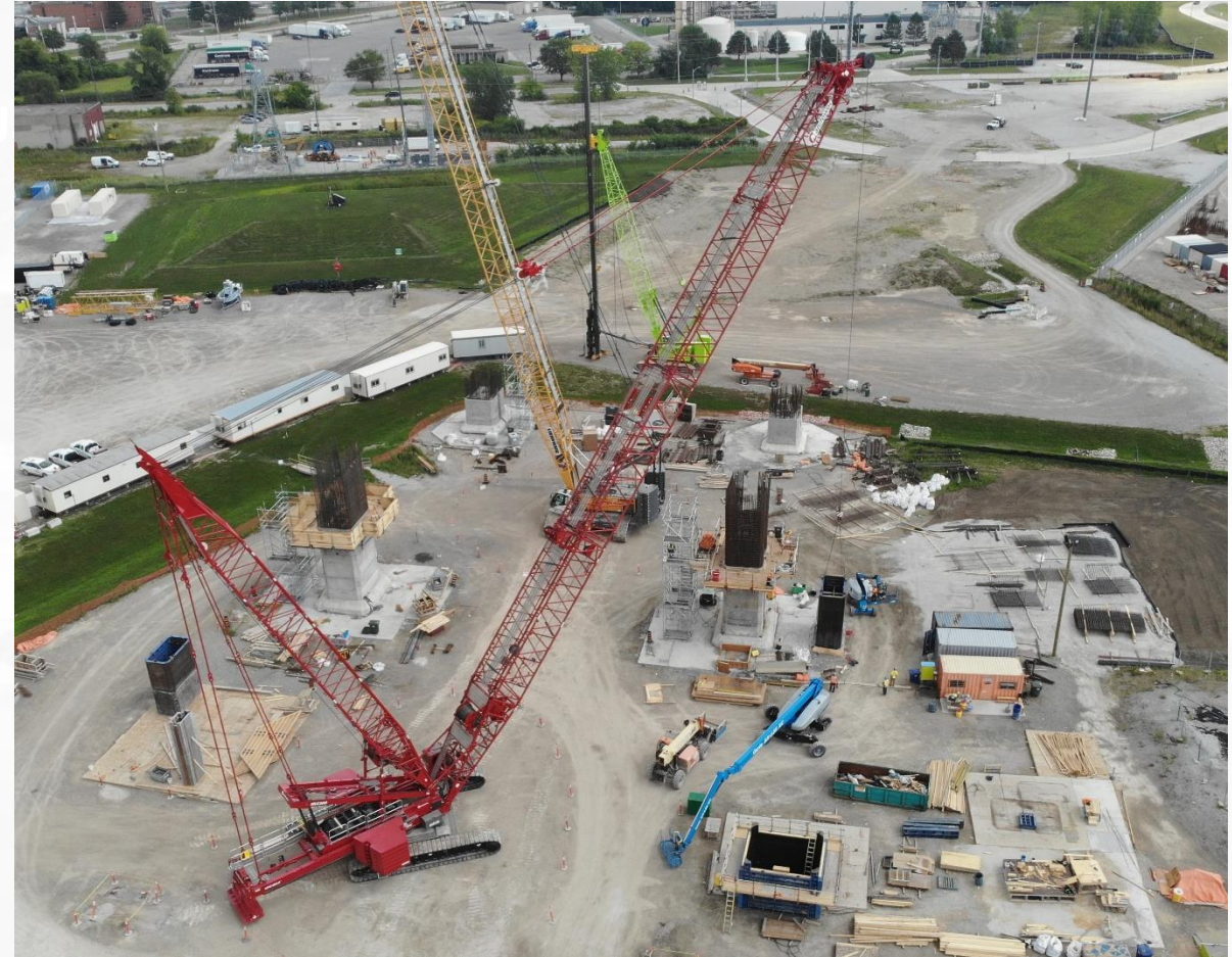
Travaux sur la tour du travée arrière du pont au Canada
