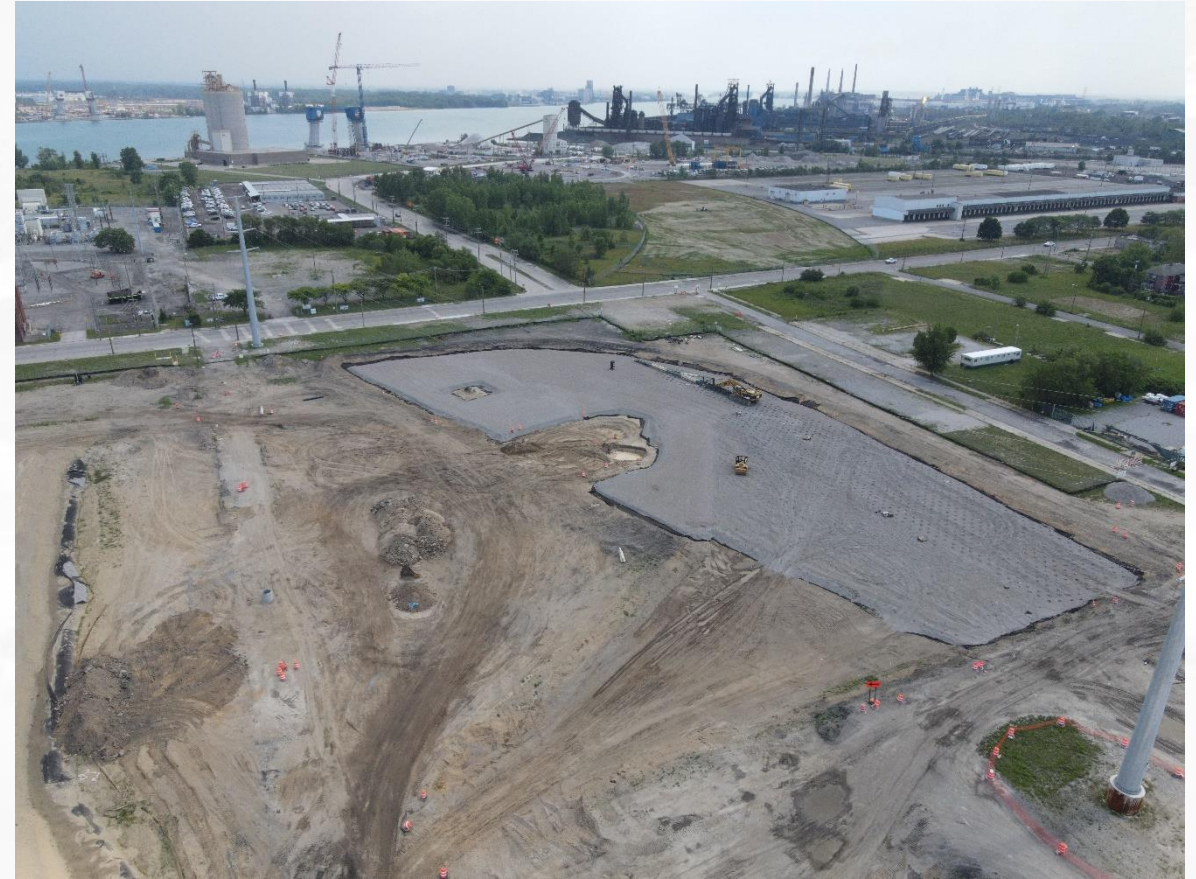
Installation de drains verticaux au PDE américain
