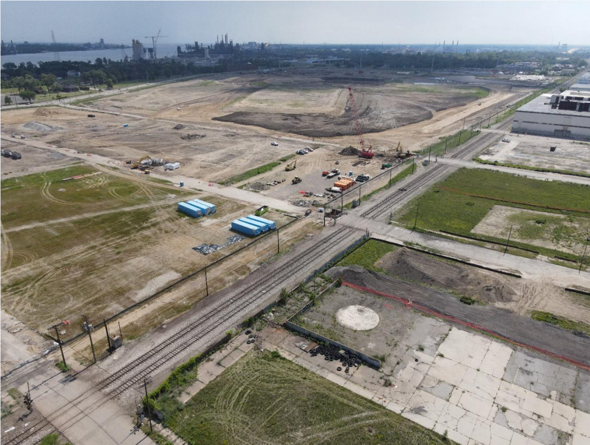
Travaux de terrassement au PDE américain
