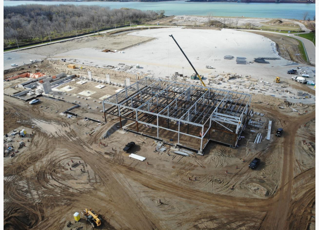
Construction du bâtiment principal du PDE canadien
