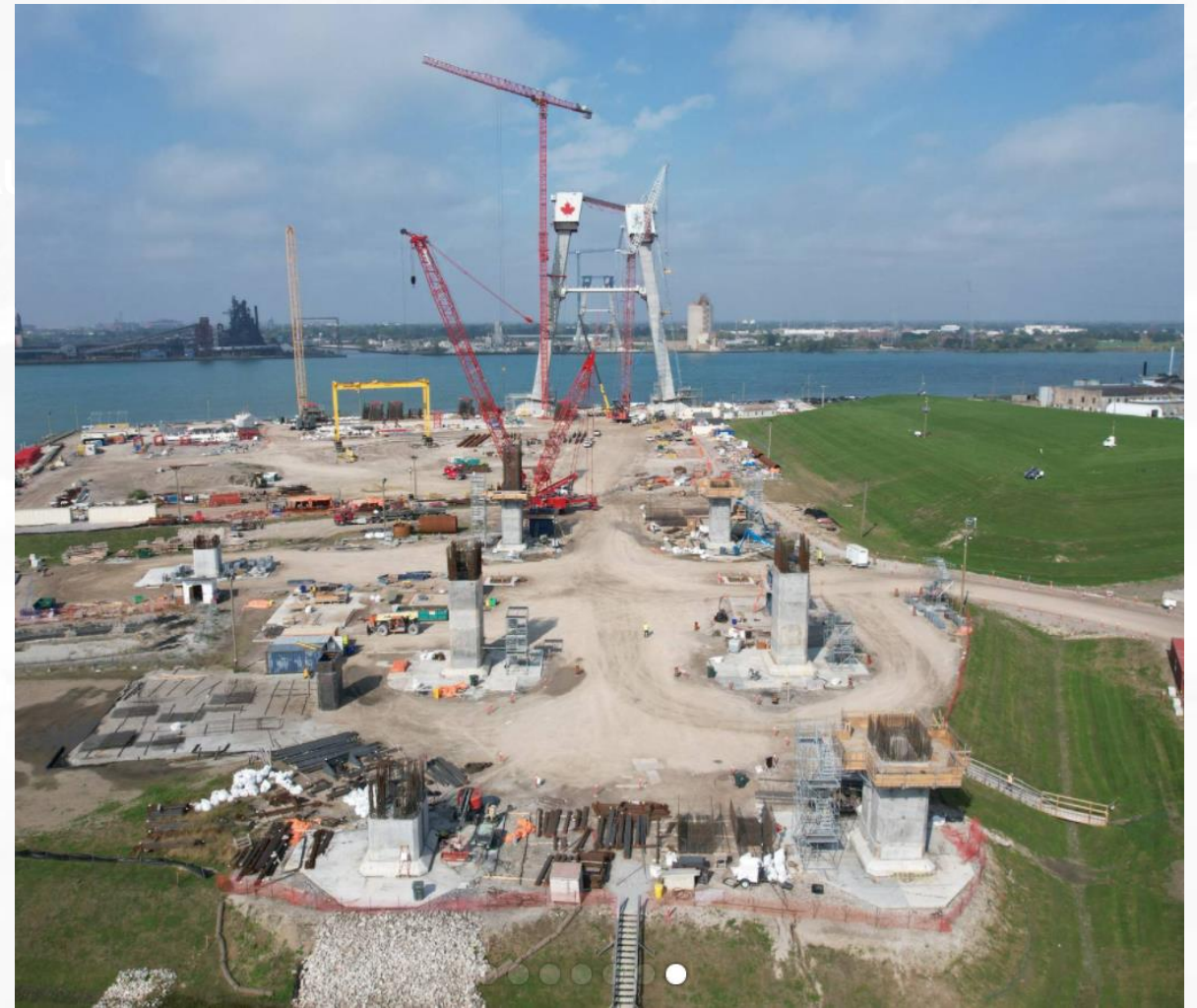
Travaux sur la tour de la travée arrière du pont au Canada
