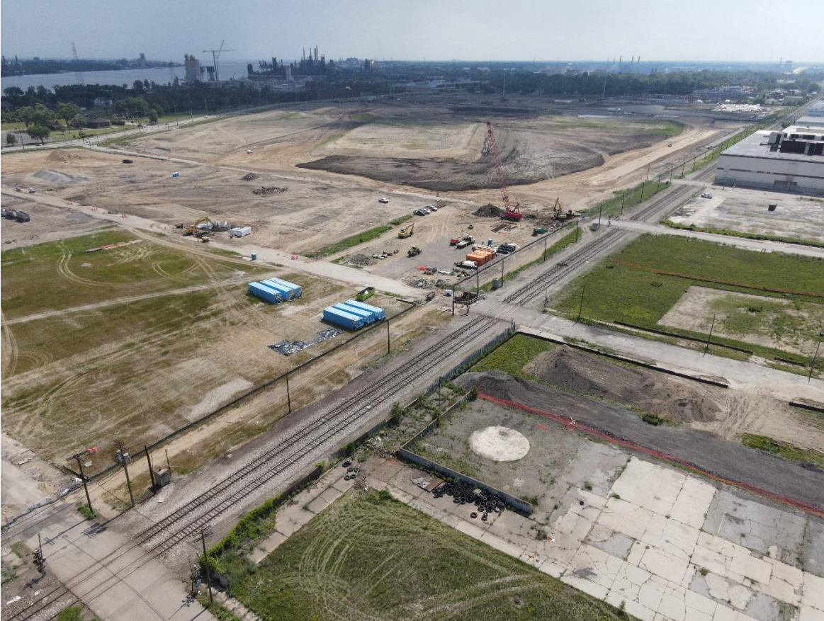
Movimiento de tierras en el Punto de entrada estadounidense
