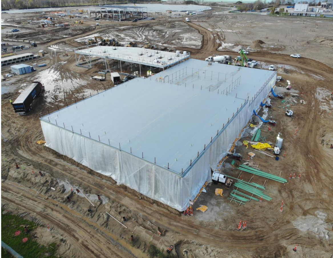
Construcción del edificio de mantenimiento en el Punto de entrada canadiense
