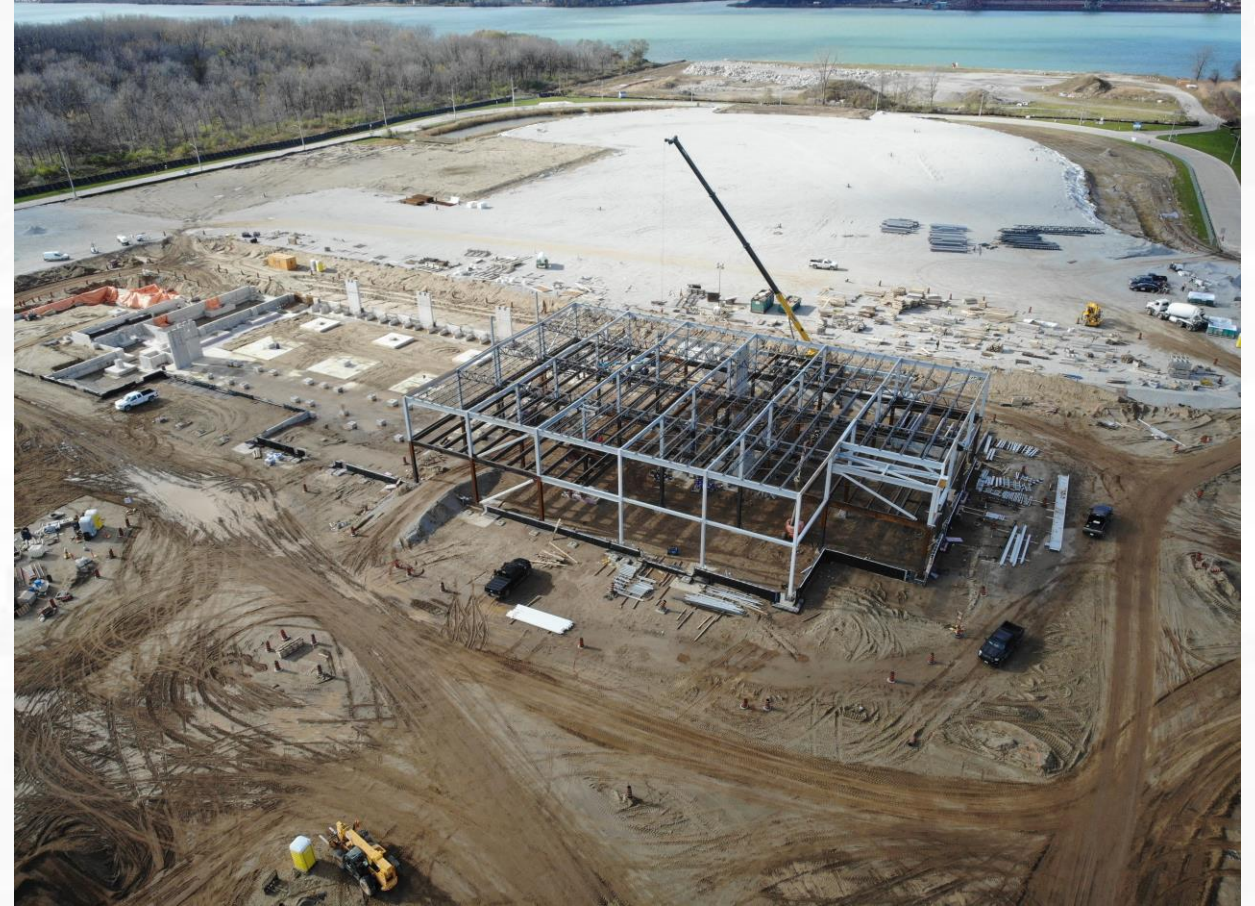
Construcción del edificio principal en el Punto de entrada canadiense
