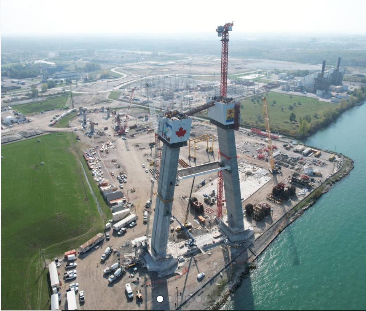
Trabajo en la torre del puente en Canadá
