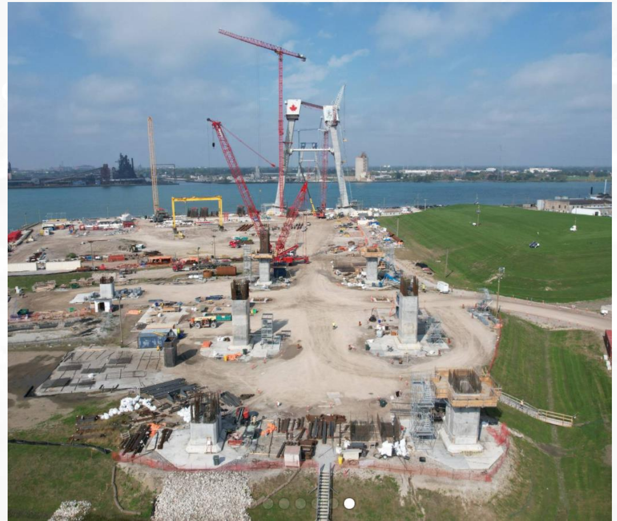
Trabajo en el tramo posterior de la torre del puente en Canadá
