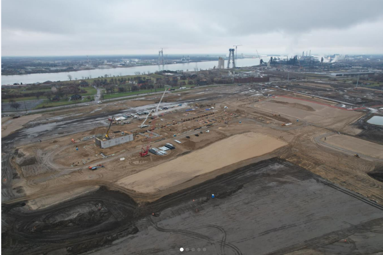
Travaux de terrassement au PDE américain
