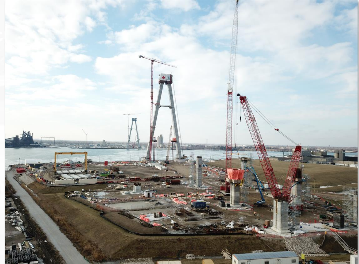
Travaux sur la tour de la travée arrière du pont au Canada
