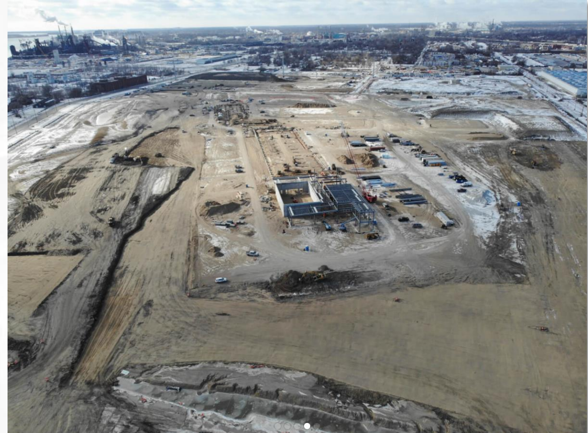
Installation de drains verticaux au PDE américain
