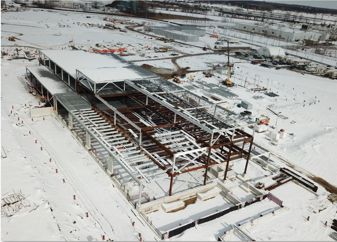
Construction du bâtiment de maintenance du PDE canadien
