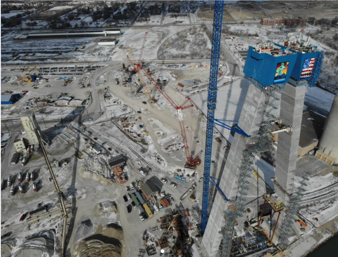
Travaux sur la tour du pont aux États-Unis
