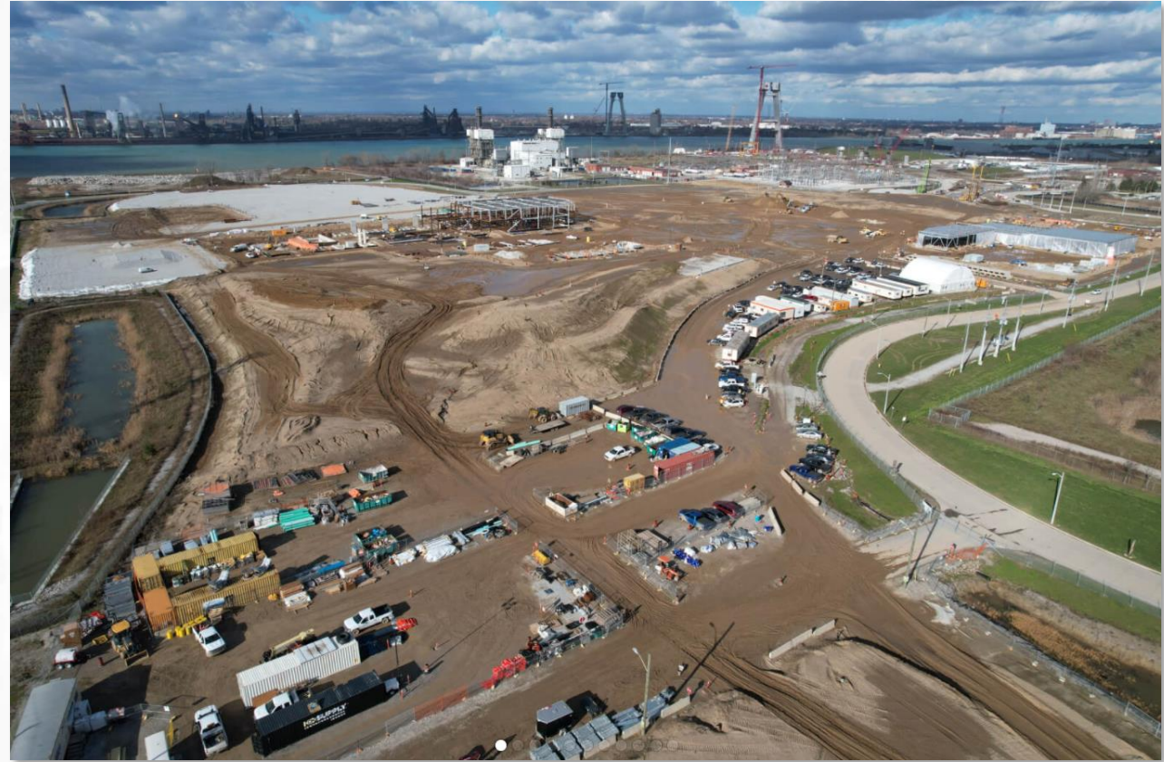
Construction du bâtiment principal du PDE canadien
