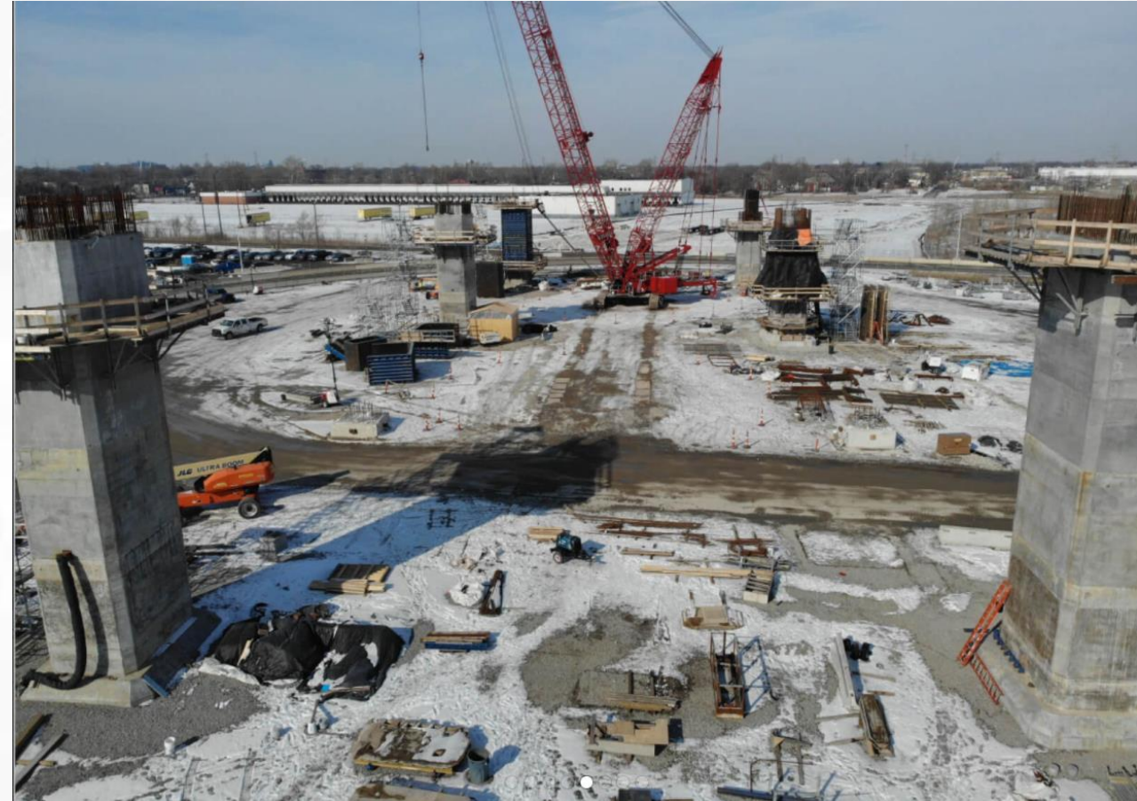
Travaux sur la travée arrière du pont aux États-Unis
