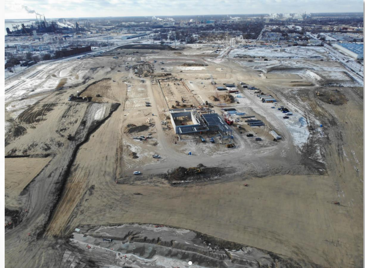
Installation de drains verticaux au PDE américain
