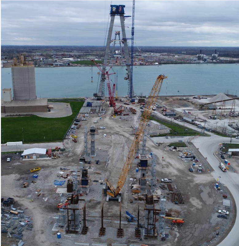
Ci-dessus : Chantier américain : travée arrière et tours du pont
