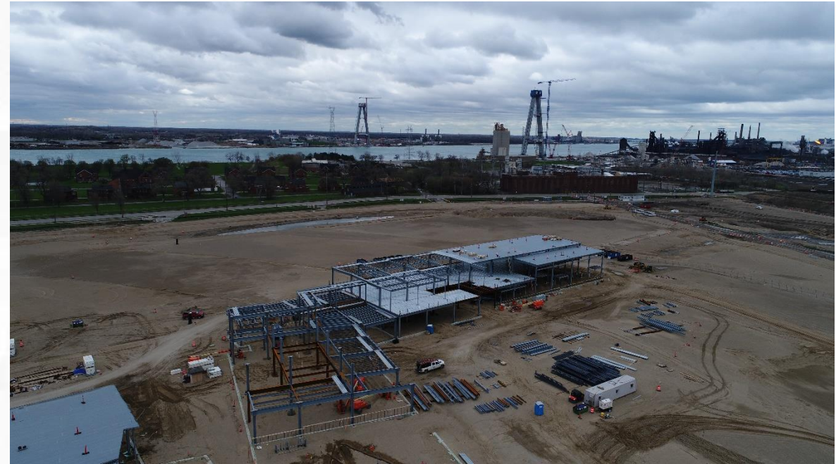
Ci-dessus : Construction du point d'entrée américain
