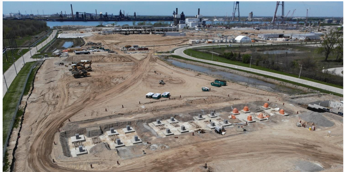
Ci-dessus : Point d'entrée canadien, construction des postes de péage
