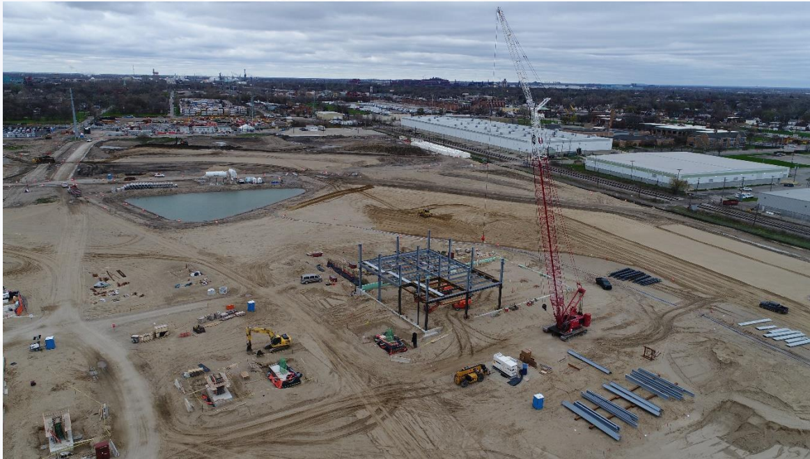
Ci-dessus : Construction du point d'entrée américain
