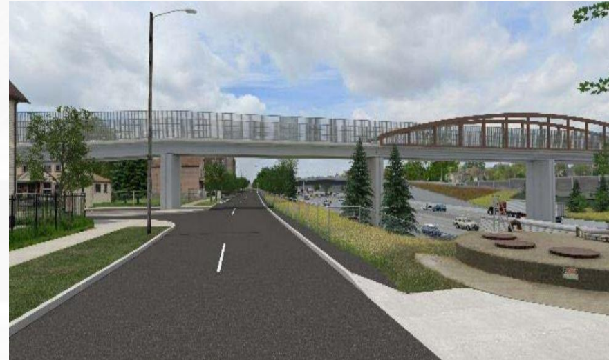
À gauche : Pont piétonnier de la rue Junction au sud de l'I-75
