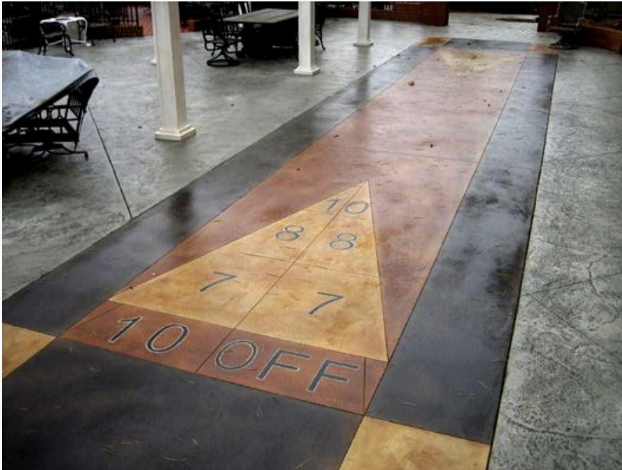
Pigments mélangés au béton
