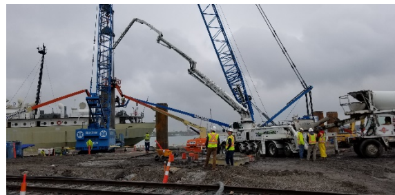
Canadian bridge site production shaft concrete pour
