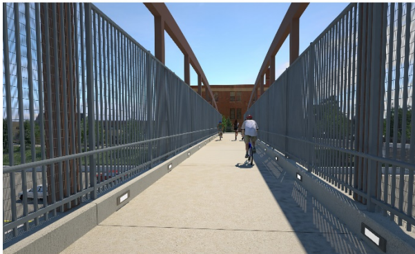
Vue de jour de la passerelle
